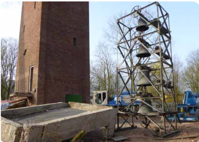
Ausbau des Glockenstuhls aus dem maroden Kirchturm 2019
