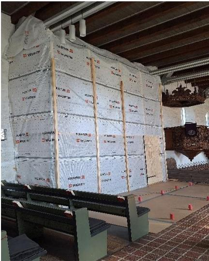
Um Stabilität der Mauer wieder herzustellen und die Feuchtigkeit aus der Wand zu lassen, muss der alte Putz entfernt und neuer Putz
