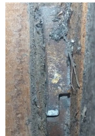
Ringdübel, teilweise freiliegend
