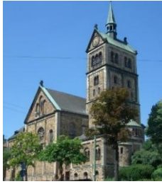
St. Maria Zentrales Pfarrbüro Kirchweg 71, 34119 Kassel
