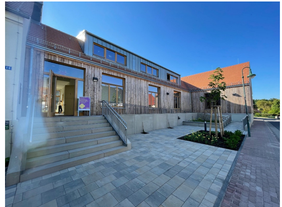
Neuer Anbau an das alte Lehniner Pfarrhaus/Gemeindehaus
