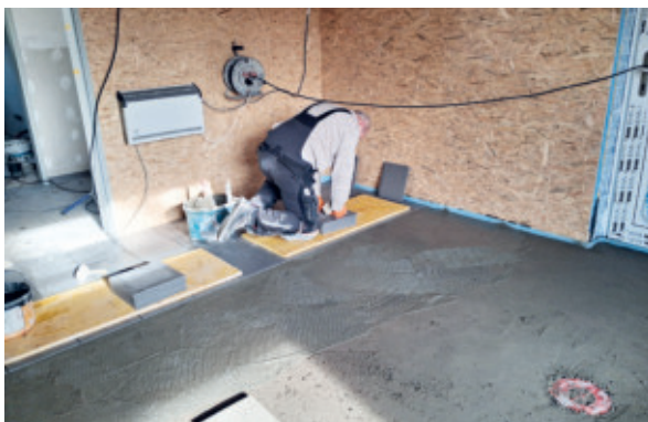
Innenarbeiten im neuen Gebäude auf dem Friedhof
