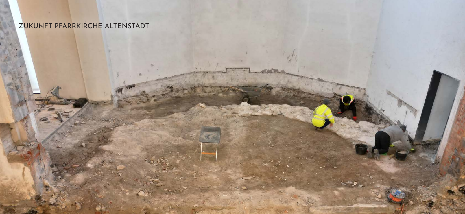
Freilegung gotischer Chor
