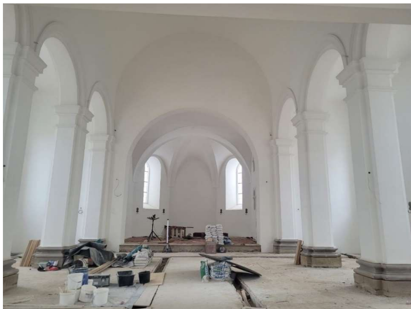
Impressionen von der Baustelle
