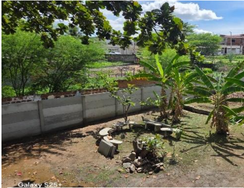
Die neue erstellte Mauer im Projektbereich Cedro
