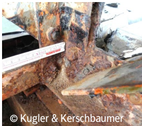
Korrosion Stahlfußpunkte
