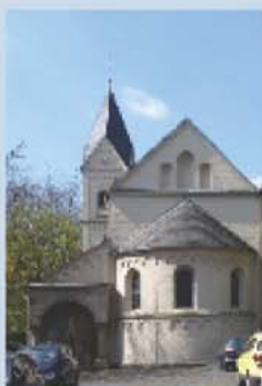
Kloster/Krankenhaus- Kapelle Neuwerk
