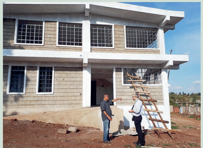
Pater Paul Chummar und Pfarrer Erich Camenzind vor der damals noch im Bau befindlichen Tagesklinik (2019).
