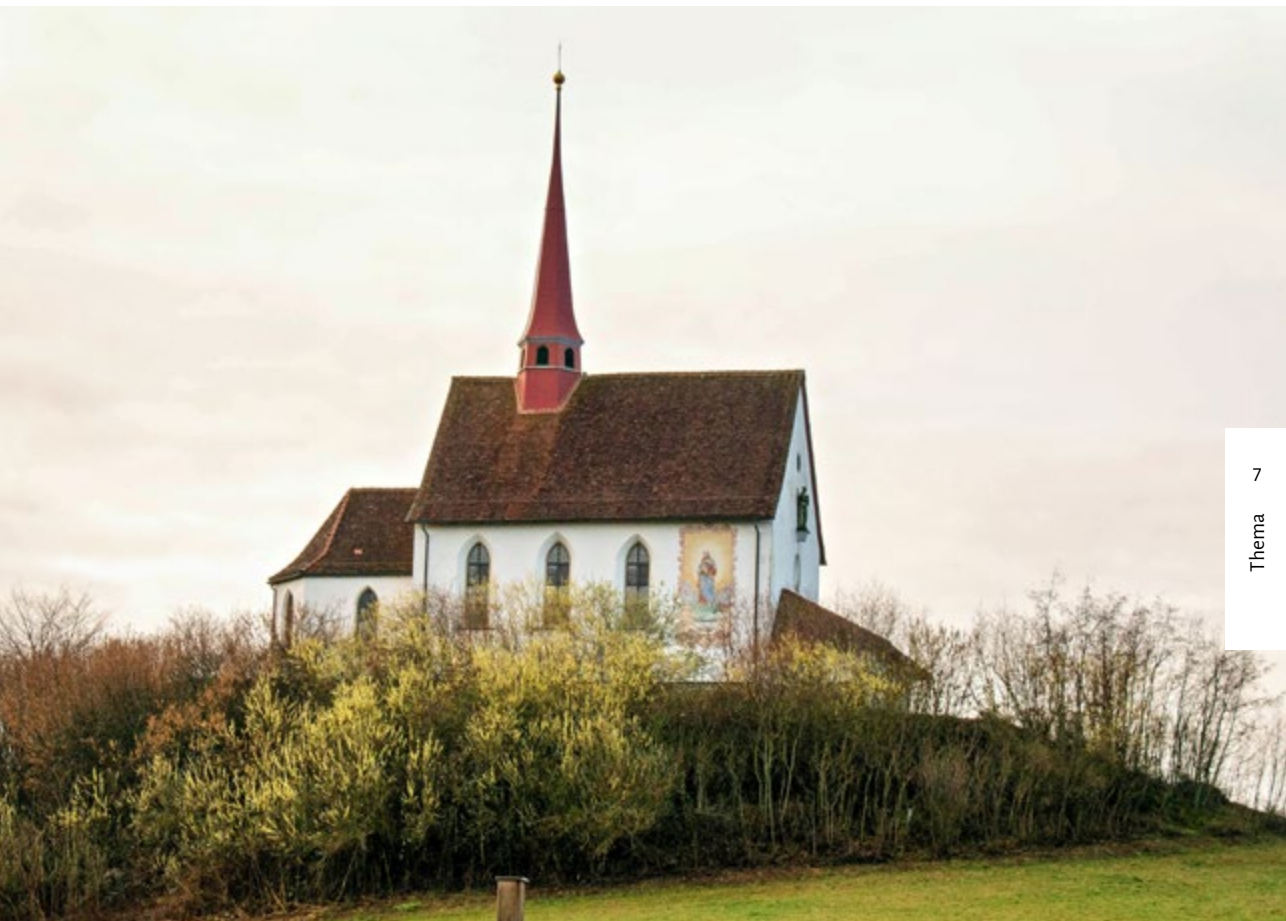
Die Wallfahrtskapelle Gormund liegt auf einem Moränenhügel und ist von Weitem sichtbar.
