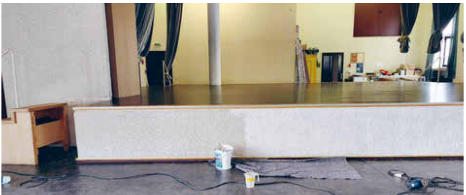
Bühne oben geschliffen und unten gestrichen
