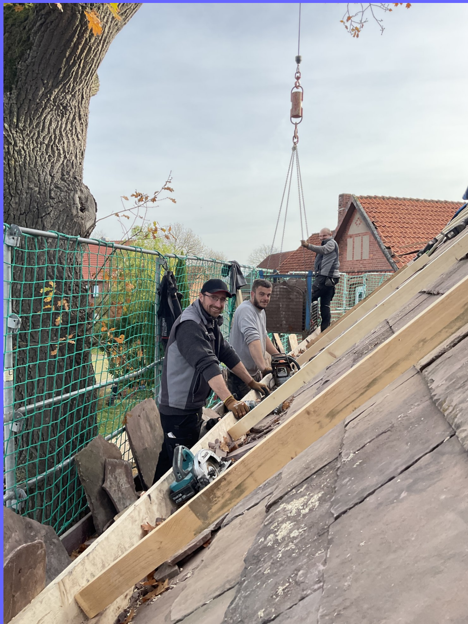
Karsten Büse, René Marszalek und Willi Hübner von der Firma Müller Bedachungen aus Entrup decken das Dach unserer Kapelle in Heßlingen neu mit Sollingplatten ein. Herzlichen Dank an alle beteiligten Handwerker und unsere Architektin Tatjana Szymanowski!
