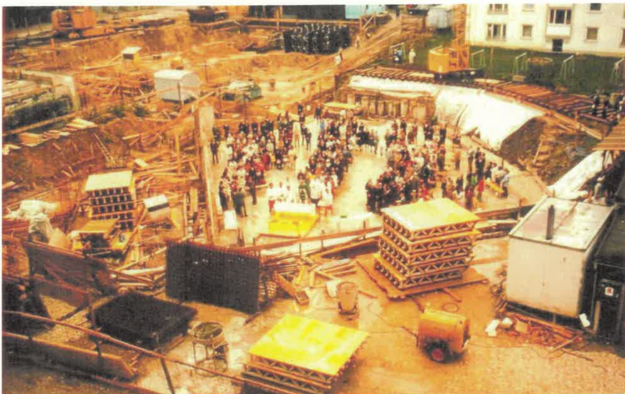
Baugrube bei der Grundsteinlegung am 30.09.1973
