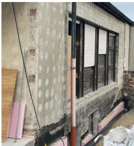
Neue energetische Dämmung am Gemeindehaus
