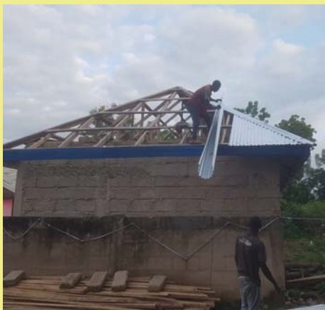
... und nun endlich mit Wellblech abgedeckt, mit unserer Hilfe
