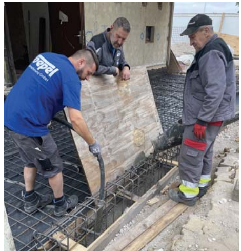
Nun wird zügig betoniert.
