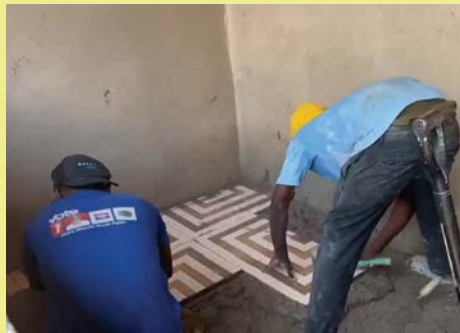
Fliesenverlegung in frisches Mörtel-Dickbett in den Gastzimmern
