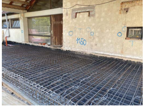
Die vordere Baugrube ist mit Flechtwerk aus Stahl ausgelegt.
